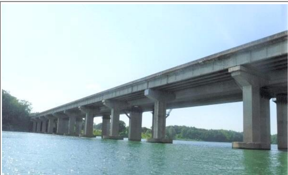
(구)남한강교 하부 전경
