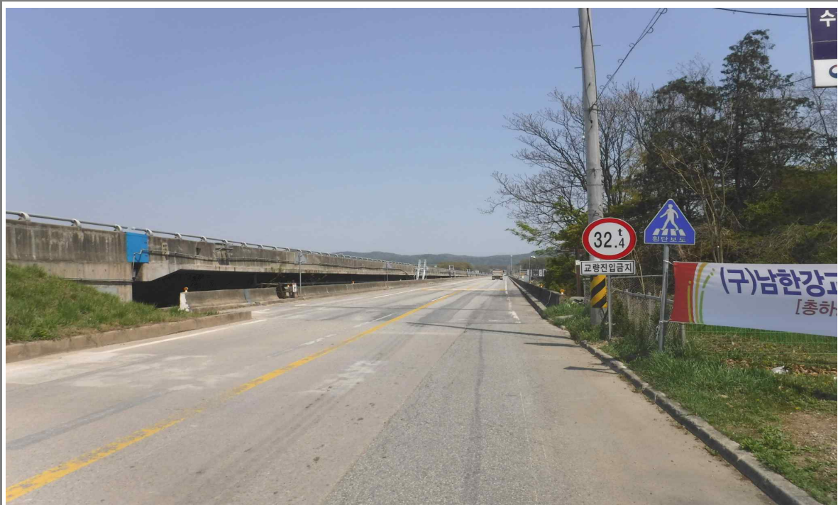
(구)남한강교 상부 전경
